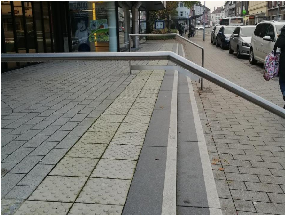
Treppenanlage mit Bodenindikatoren und kontrastreicher Gestaltung, Schwerte
