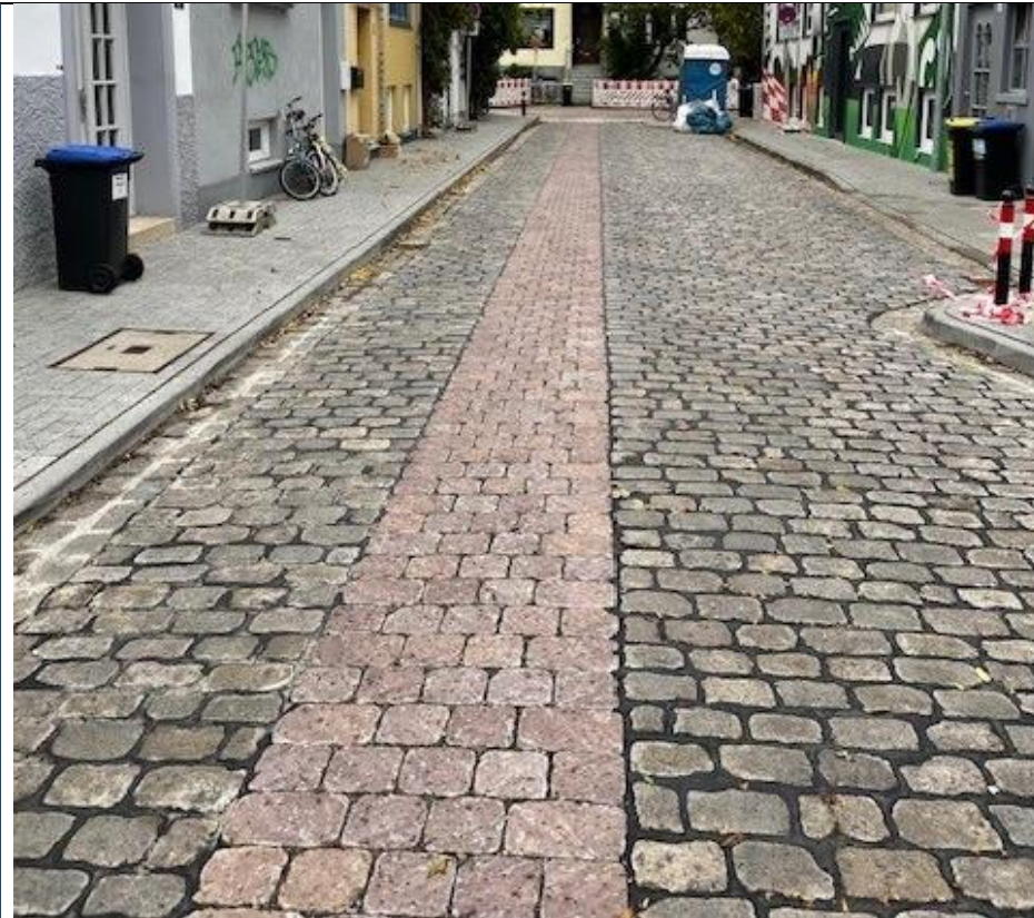
Barrierefreier Querungsbereich (geschliffenes Pflaster), Münster
