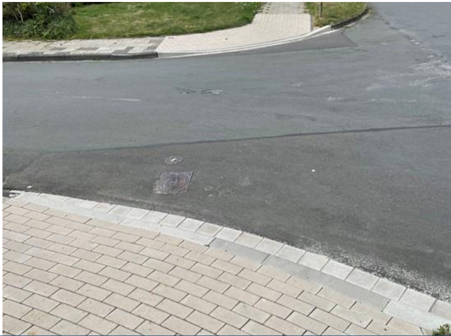
Einfache Bordsteinabsenkung, Billerbeck
