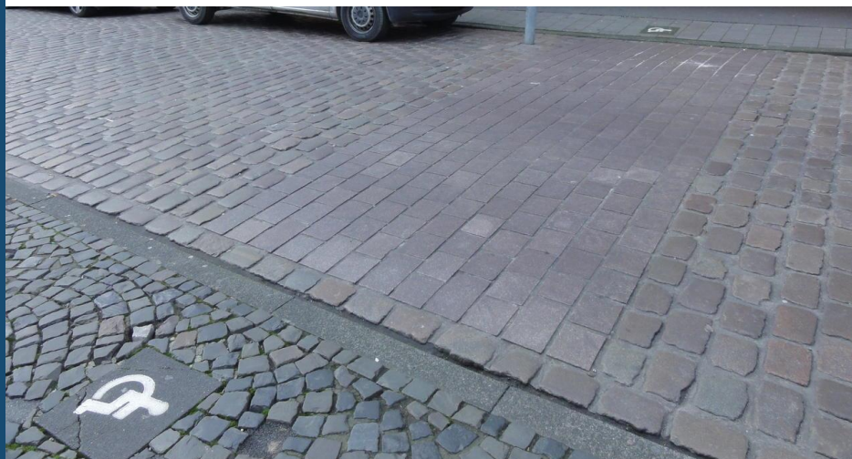
Barrierefreier Querungsbereich (geschliffenes Pflaster), Münster
