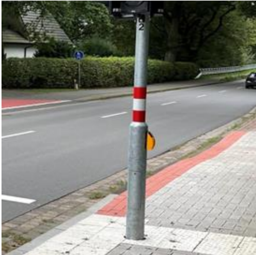
Retroreflektoren an einem LSA-Mast, Ganderkesee
